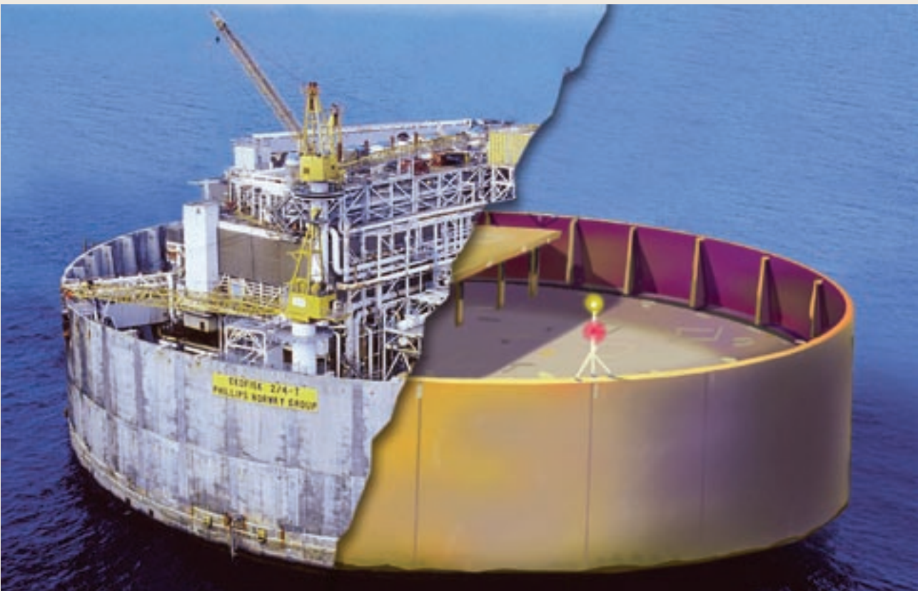
Figur 7.2 Illustrasjon av Ekofisktanken før og etter fjerning av overbygninga
