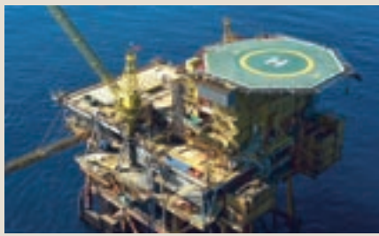
Figur 7.1 Bore- og produksjonsinnretninga DP2 som blei fjerna frå Friggfeltet i 2008 (Kjelde: Total E&P Norge AS)
