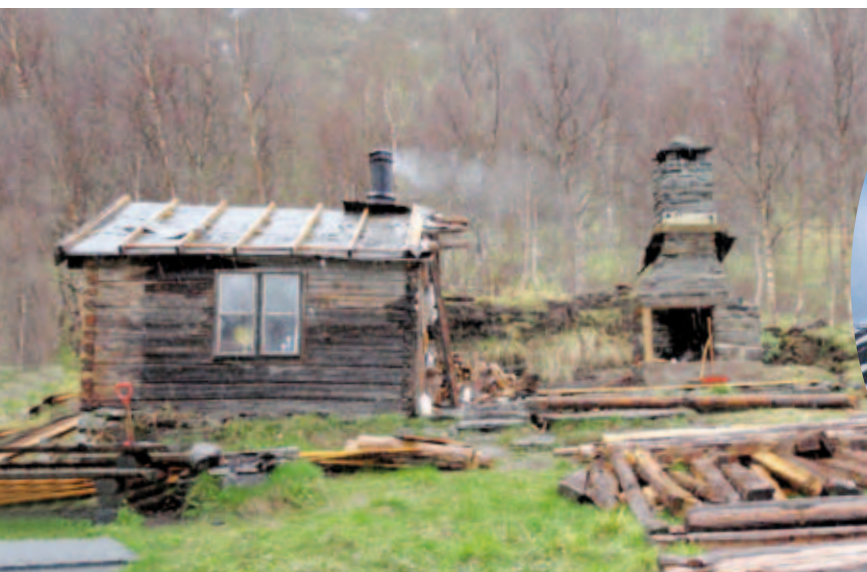
Den ene delen av gammelhuset var i så dårlig forfatning at det måtte rives og tømres opp på nytt.
