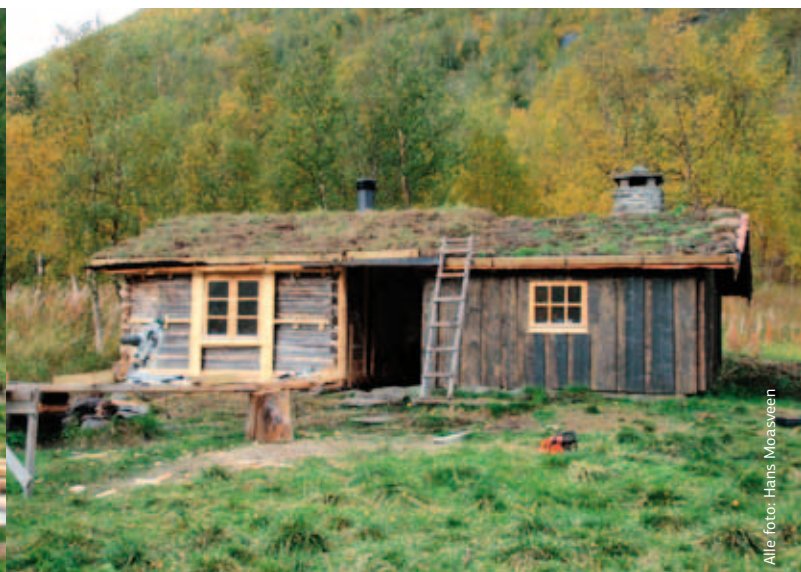
Stormdalsgården, slik den ser ut etter restaureringsarbeidet, september 2009.
