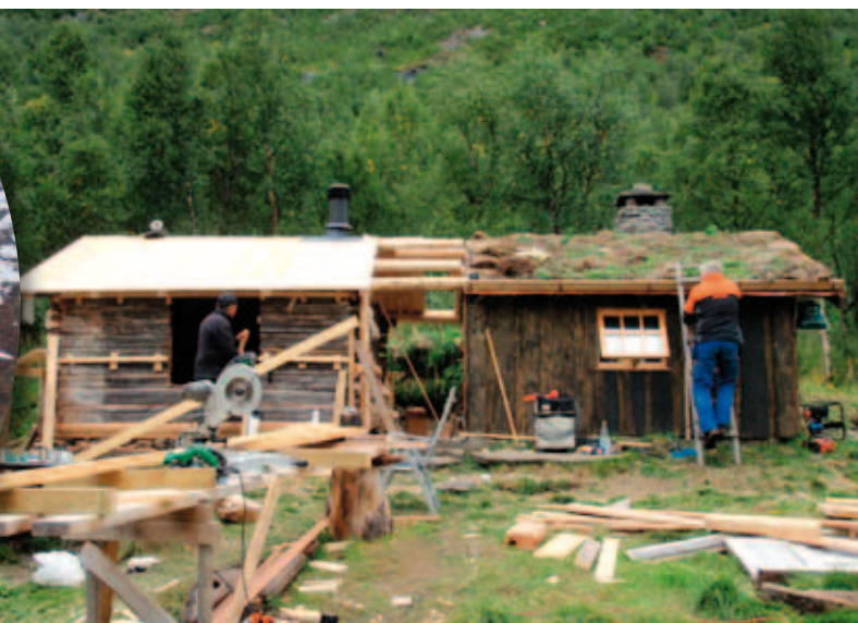
Det jobbes med den nye delen av huset.
