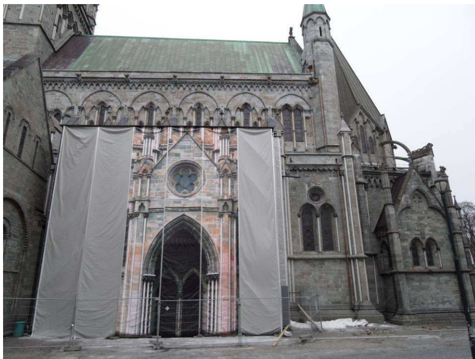
Kongeinngangen med stillas – gjengitt på stillasduken.
