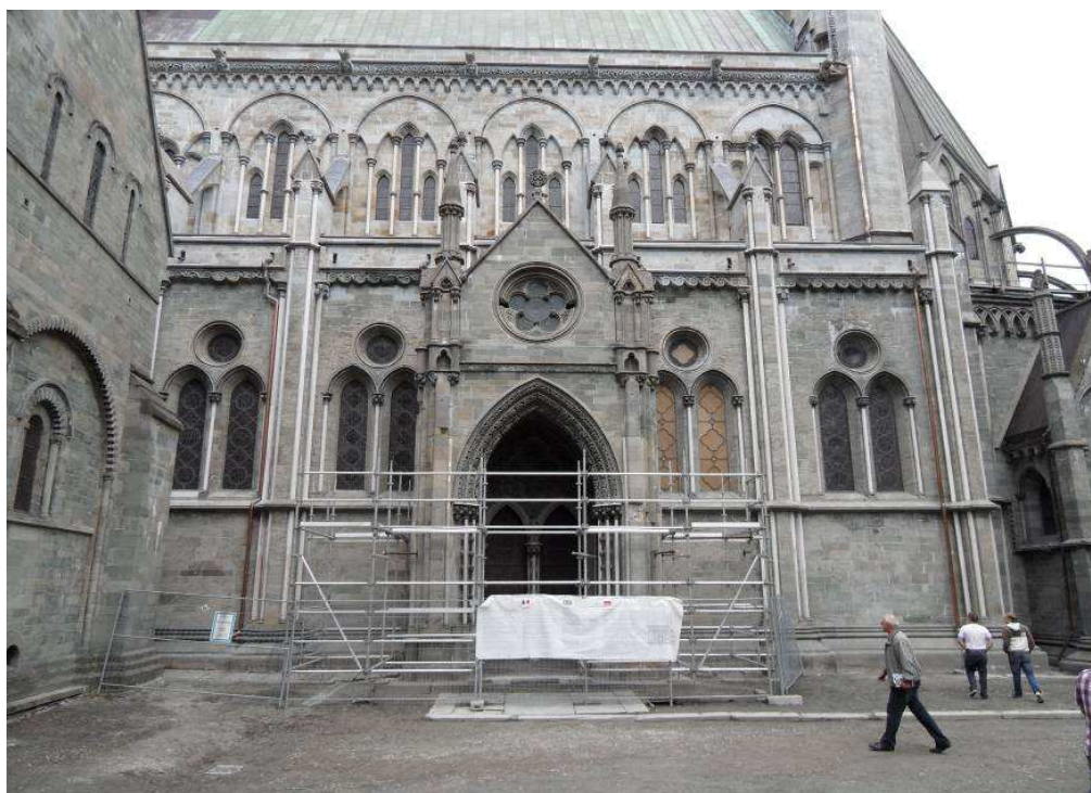
Korets søndre fasade ferdig restaurert
