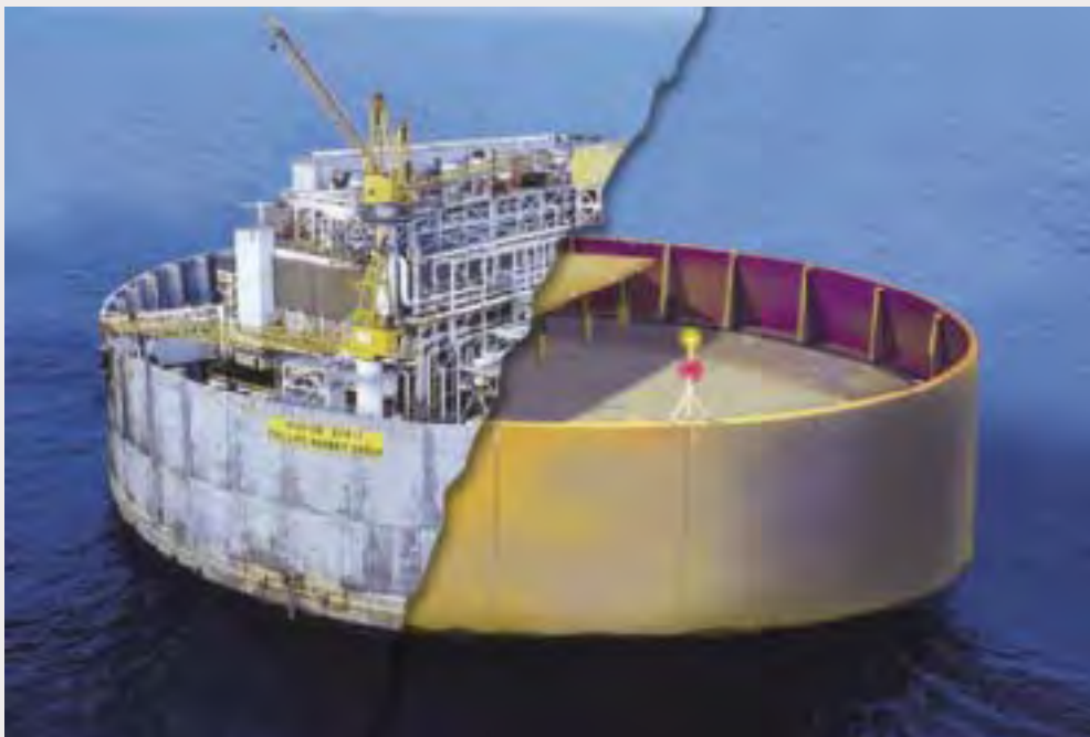
Figur 7.2 Illustrasjon av Ekofisk-tanken før og etter fjerning av overbygninga
