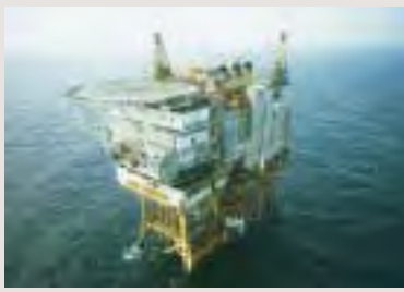
Figur 7.1 Pumpeinnretninga 37/4-A der understellet etter planen skal fjernast sommaren 2010 (Kjelde: ConocoPhillips)
