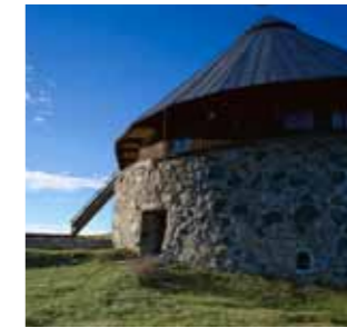
Stavern fort, Citadelløya. Foto: Jiri Havran
