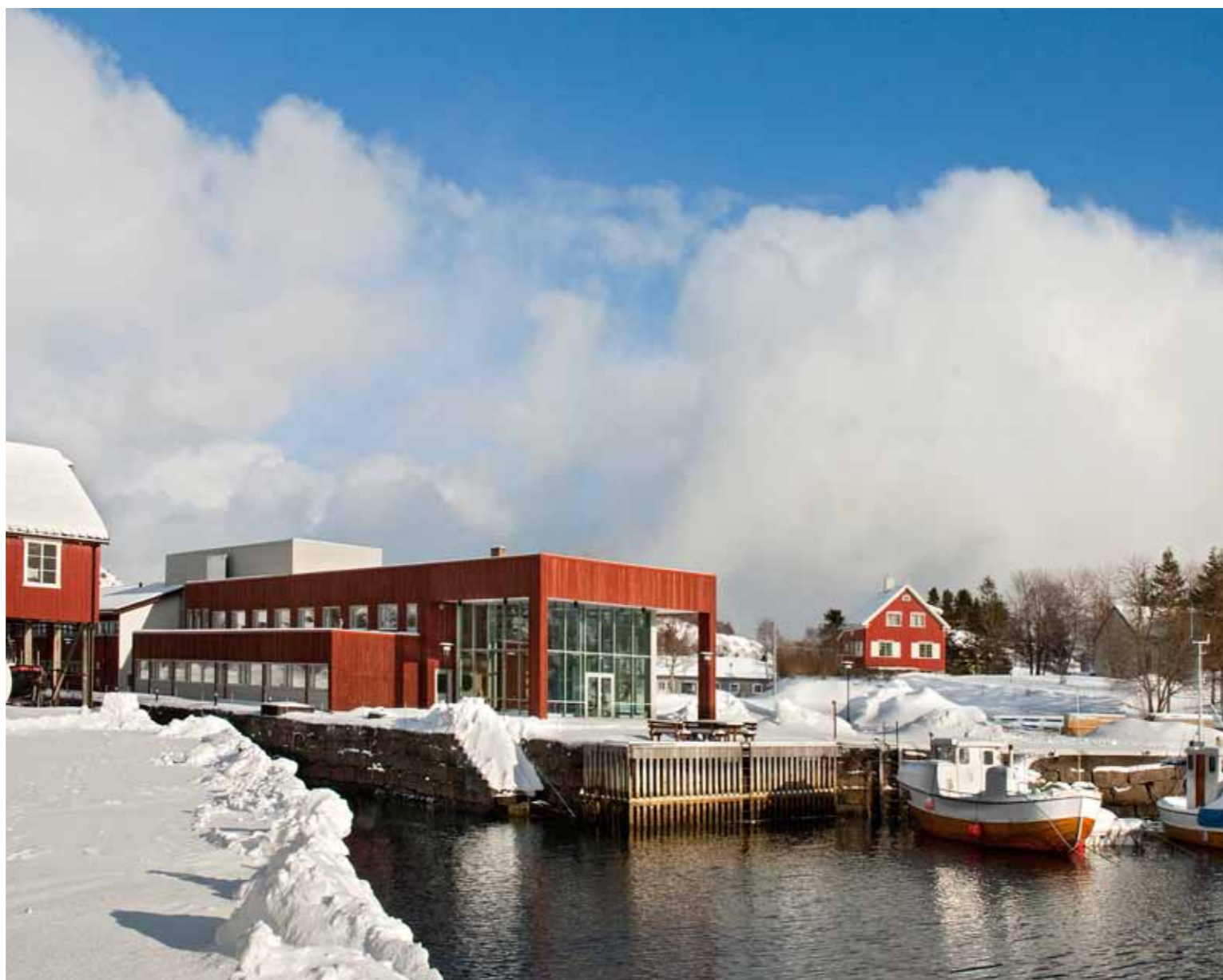
Kystverket Kabelvåg. Foto: Jaro Hollan. Arkitekt: Prosjektservice
