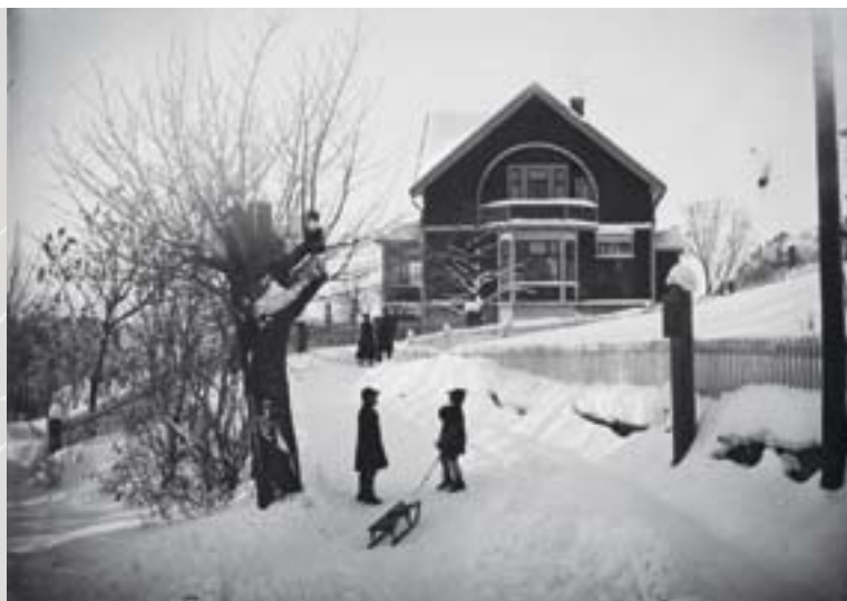
Arkivmagasinet 1/10 handlet om statlige bygg. Fotografiet viser bolig for politimesteren i Drammen.
