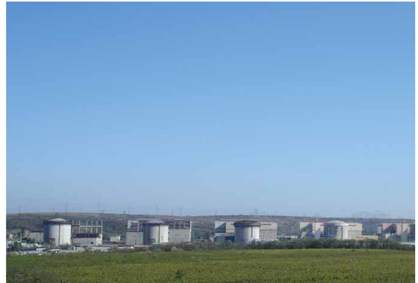
Cernavoda kjernekraftanlegg i Romania. Foto: Pavel Tishakov, Statens strålevern.
