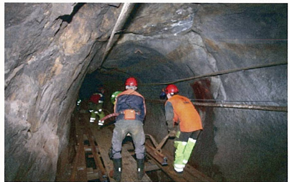
Fra utskifting av skinnegang i Christian 7. stoll.
