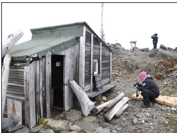
Dokumentasjon av bistasjon på Wilczekodden. Foto: Trine Krystad/ Sysselmannen på Svalbard
