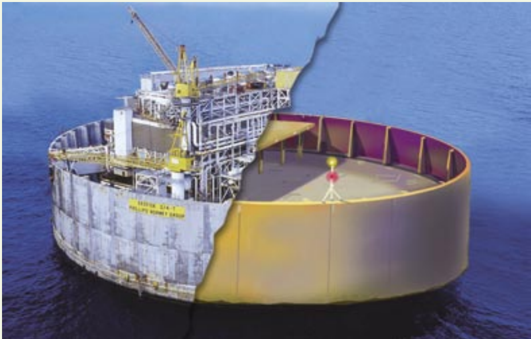
Figur 6.7 Illustrasjon av Ekofisktanken før og etter fjerning av overbygninga (Kjelde: ConocoPhillips)
