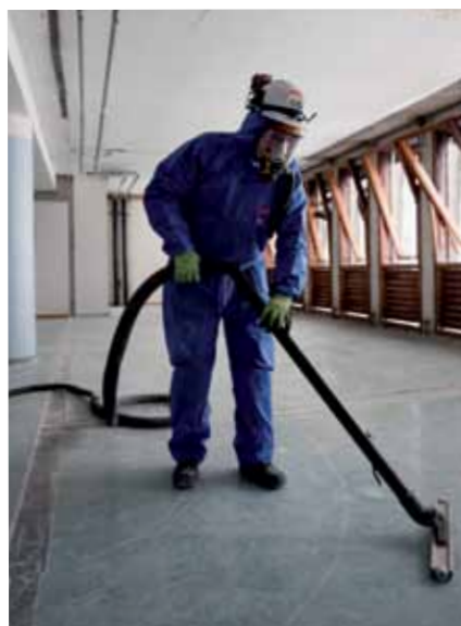
I Høyblokken har det etter bomben vært for høyt asbestnivå noe som har bydd på ekstra utfordringer. Alle gjenstander som har vært inne i bygget, må renses før de kan tas ut, og dette er tidkrevende arbeid.
