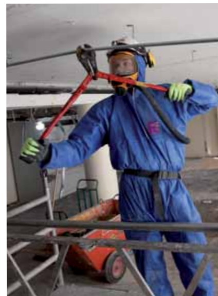
I Høyblokken har det etter bomben vært for høyt asbestnivå noe som har bydd på ekstra utfordringer. Alle gjenstander som har vært inne i bygget, må renses før de kan tas ut, og dette er tidkrevende arbeid.
