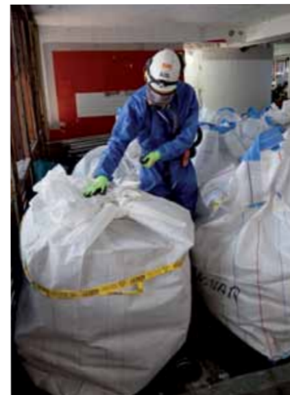
Det er også foretatt asbestmålinger både inne og ute, og det er ikke registrert asbest i uteluft. Innvendig jobber alle med verneutstyr.
