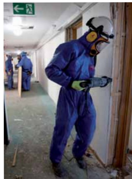
I Høyblokken har det etter bomben vært for høyt asbestnivå noe som har bydd på ekstra utfordringer. Alle gjenstander som har vært inne i bygget, må renses før de kan tas ut, og dette er tidkrevende arbeid.
