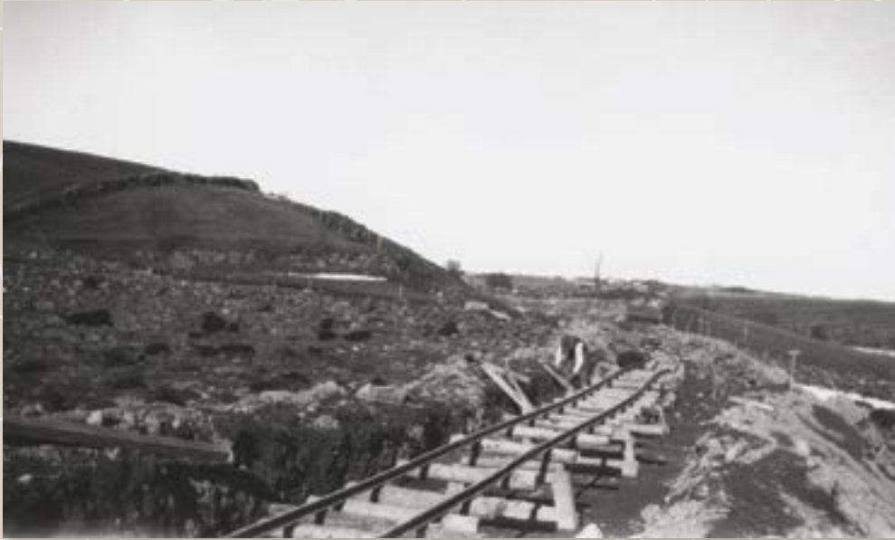
Arkivmagasinet 1/11 hadde jernbane-arkivene som hovedtema. Dette bildet er hentet fra anlegget av Ålgårdsbanen mellom Ganddal og Ålgård, 1924. Arbeiderne fyller dreneringsmasse i traséen. Ukjent fotograf. Original i Statsarkivet i Stavanger (1993-5-304). Utsnitt.
