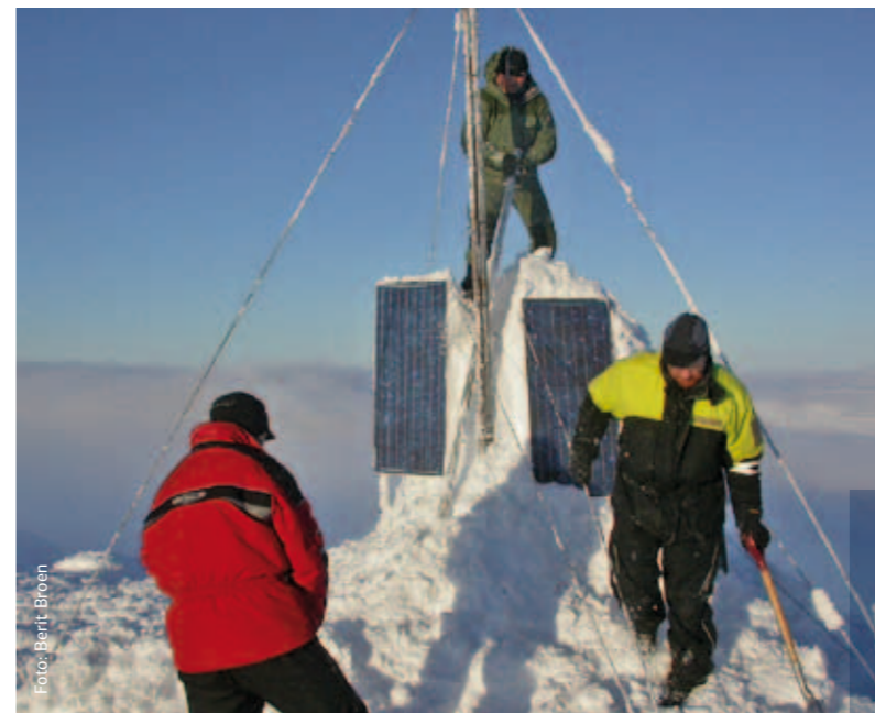
For å oppnå størst mulig dekning blir basestasjonene plassert høyt til fjells eller andre sentrale punkter, gjerne utilgjengelige steder, med de driftsproblemer dette innebærer. Spesielt i høyfjellet om vinteren med store islaster på hus-, antennebærere og ikke minst antenner.
