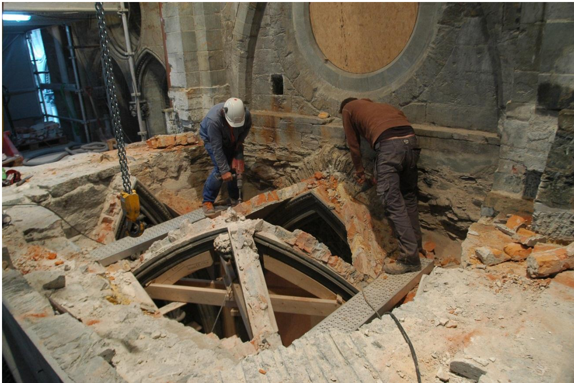
Hvelvkappene på Kongeinngangen under demontering.
