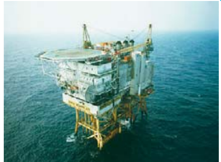
Figur 6.6 Pumpeinnretninga 37/4A, der understellet vart fjerna sommaren 2010 (Kjelde: ConocoPhillips)
