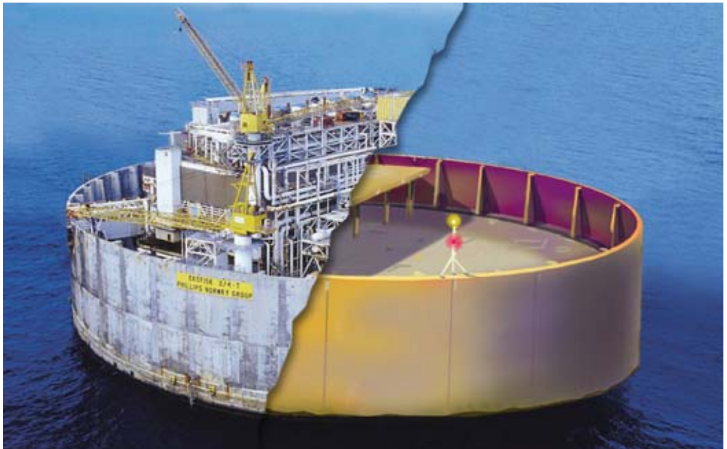
Figur 6.7 Illustrasjon av Ekofisktanken før og etter fjerning av overbygninga (Kjelde: ConocoPhillips)
