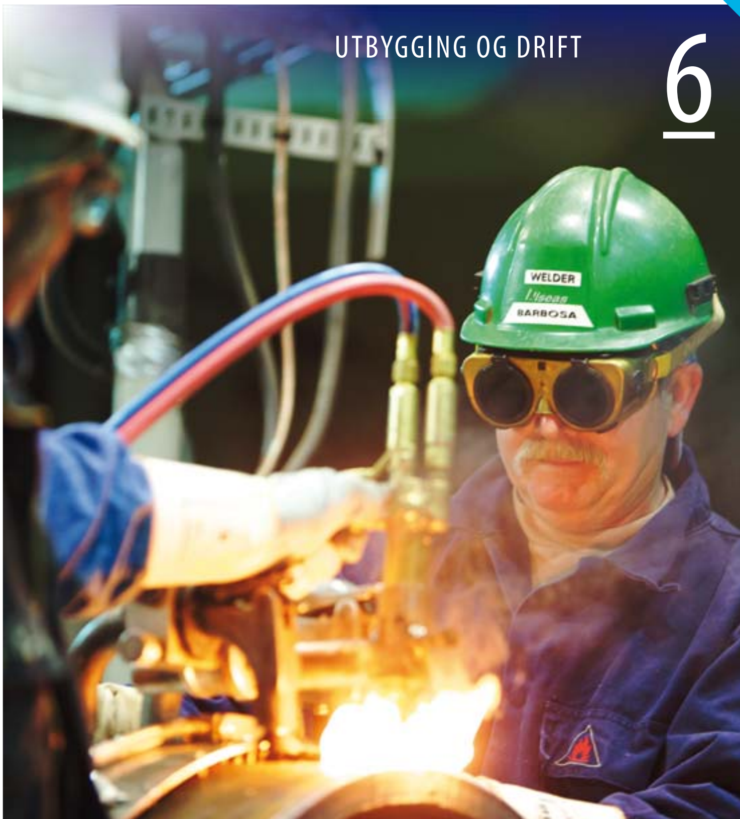
Sveisesaumane må vere pinlig nøyaktige under legging av rørleidningar på norsk sokkel. (Foto: Anette Westgaard, Statoil)
