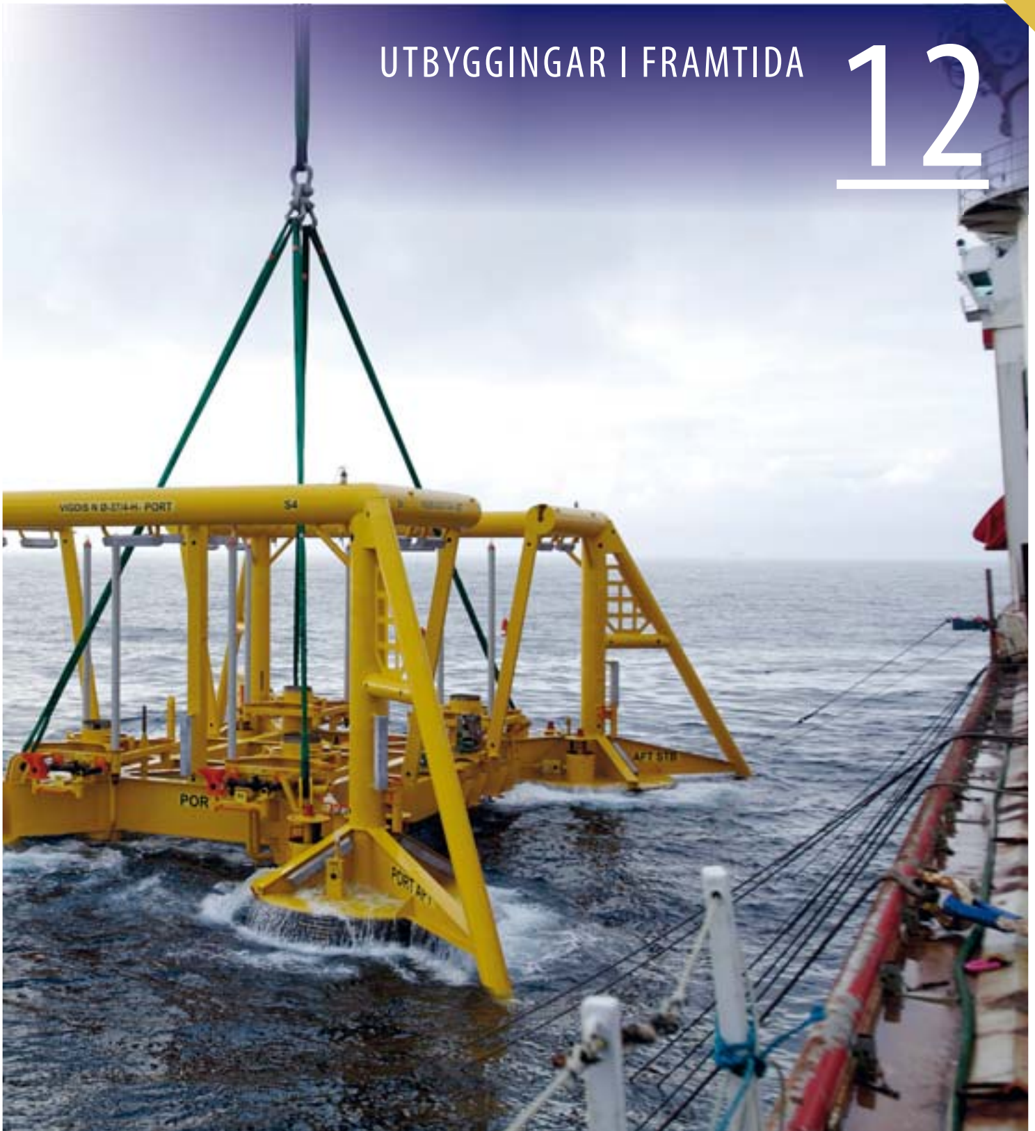
Stadig flere felt blir bygt ut med undervassinnretninger. Her frå installeringa på Vigdis Øst. (Foto: A. Osmundsen, Statoil)
