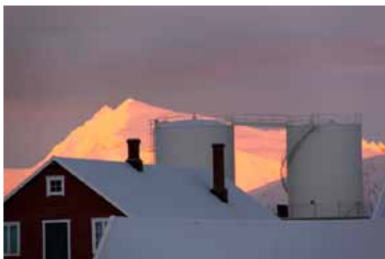
Nyoppusset tankanlegg. Foto: Ole Øiseth
