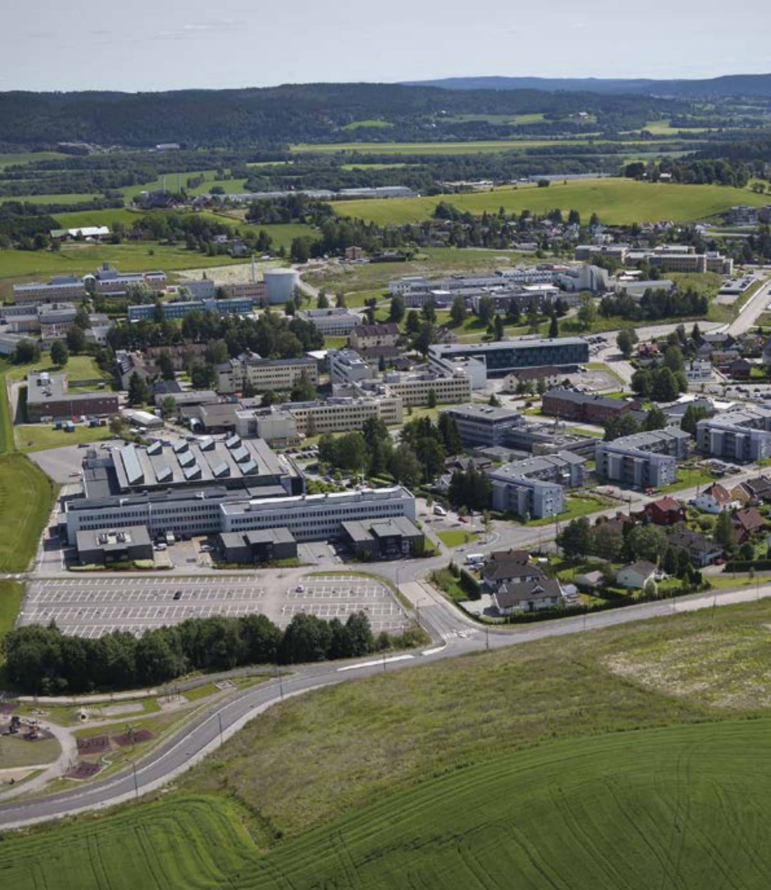
Kjellerområdet. Foto: Jan H. Aspen
