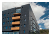
Bygger Papirbredden 2 i Drammen
