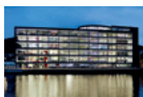
Bygger Papirbredden i Drammen
