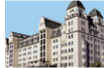
Kjøper Havnelageret i Oslo
