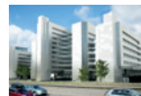
Rehabiliterer Fredrik Selmers vei 4 i Oslo
