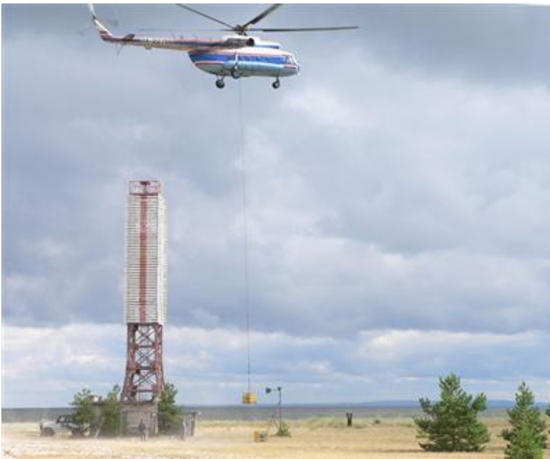
Figur 4.5.4.2.1 Fjerning av radioaktive strontiumbatterier i Østersjøen. Foto: Per Einar Fiskebeck, Fylkesmannen i Finnmark.
