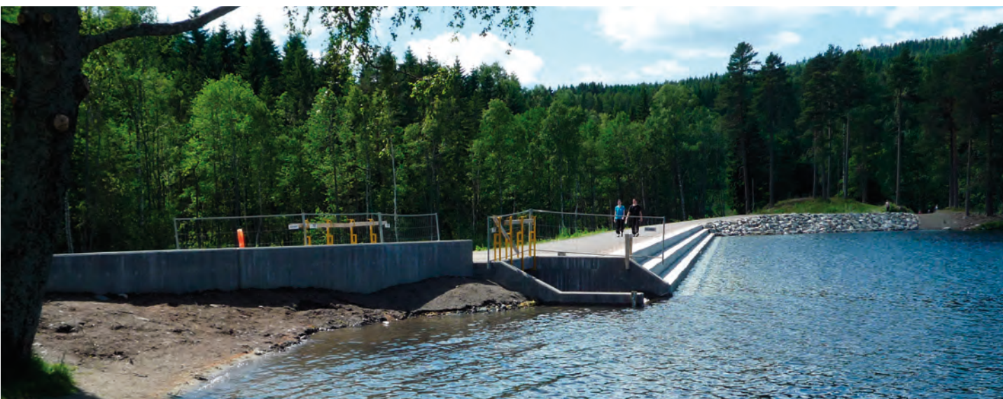
Dam Sognsvann i Oslo. Dammen ble fornyet i løpet av 2011 og 2012, da dammen ikke tilfredstilte ulike konstruktive krav gitt i dam sikkerhetsforskriften. I tillegg til at dam sikkerheten er ivaretatt, er det laget publikumsvennlige løsninger ved fornyelsen av dammen. Foto: Roar Sivertsgård/NVE
