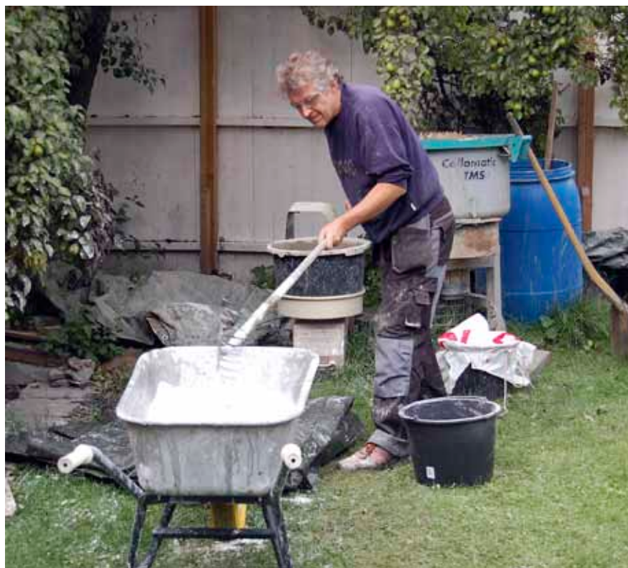
Tradisjonsmurer Viggo Ballo fra Levanger lesker kalk i forbindelse med en åpen visning av et istandsettingsprosjekt.
