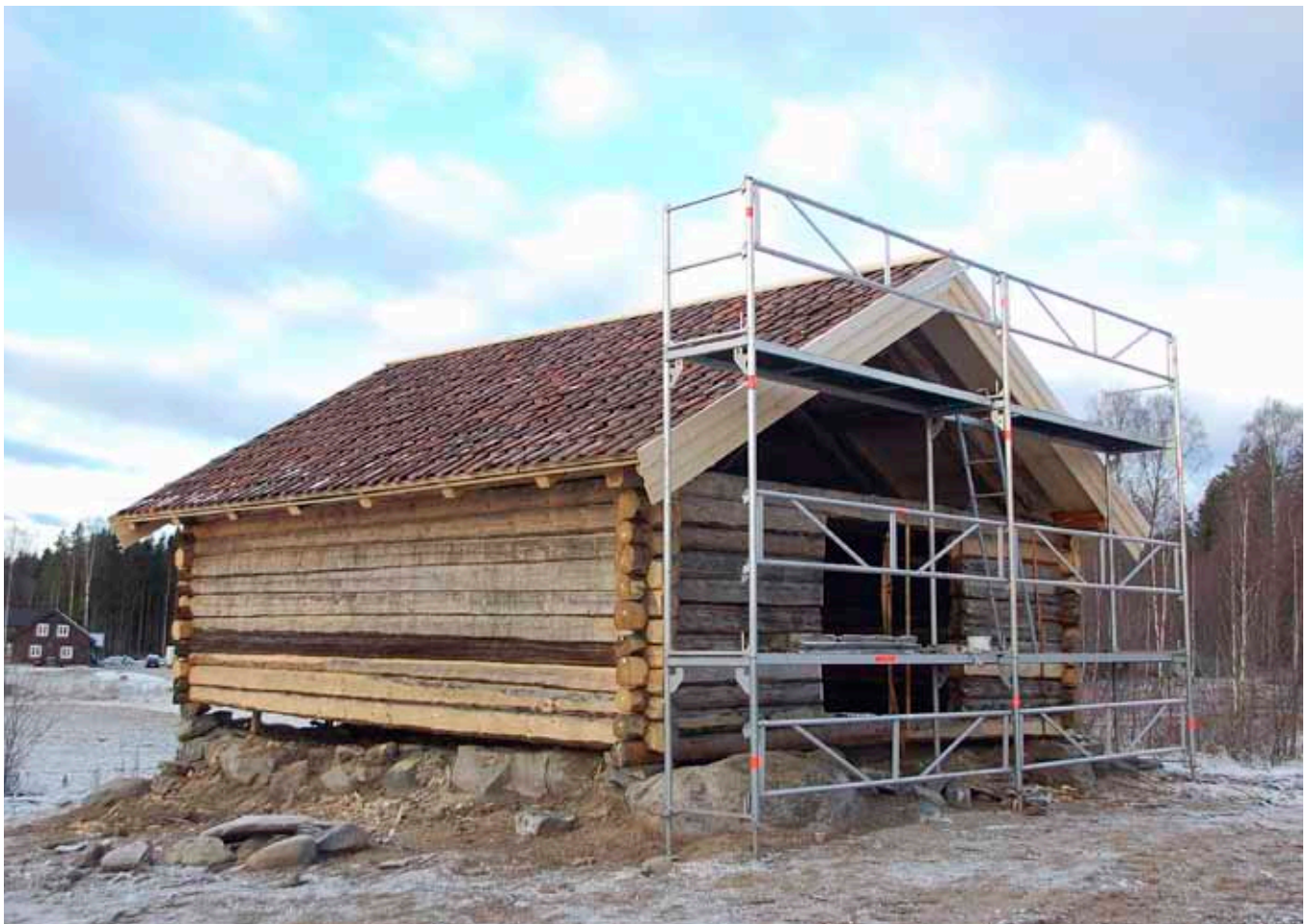
Bildene viser kjellerbua før, under og etter istandsetting. Foto: Ole Jakob Holt
