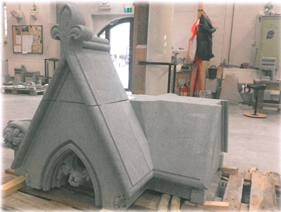
Gavlsteiner ferdig hugget på Kongeinngangens østlige tårn. Mye godt håndverk utført her, både av profil og ornamentikkhugging.
