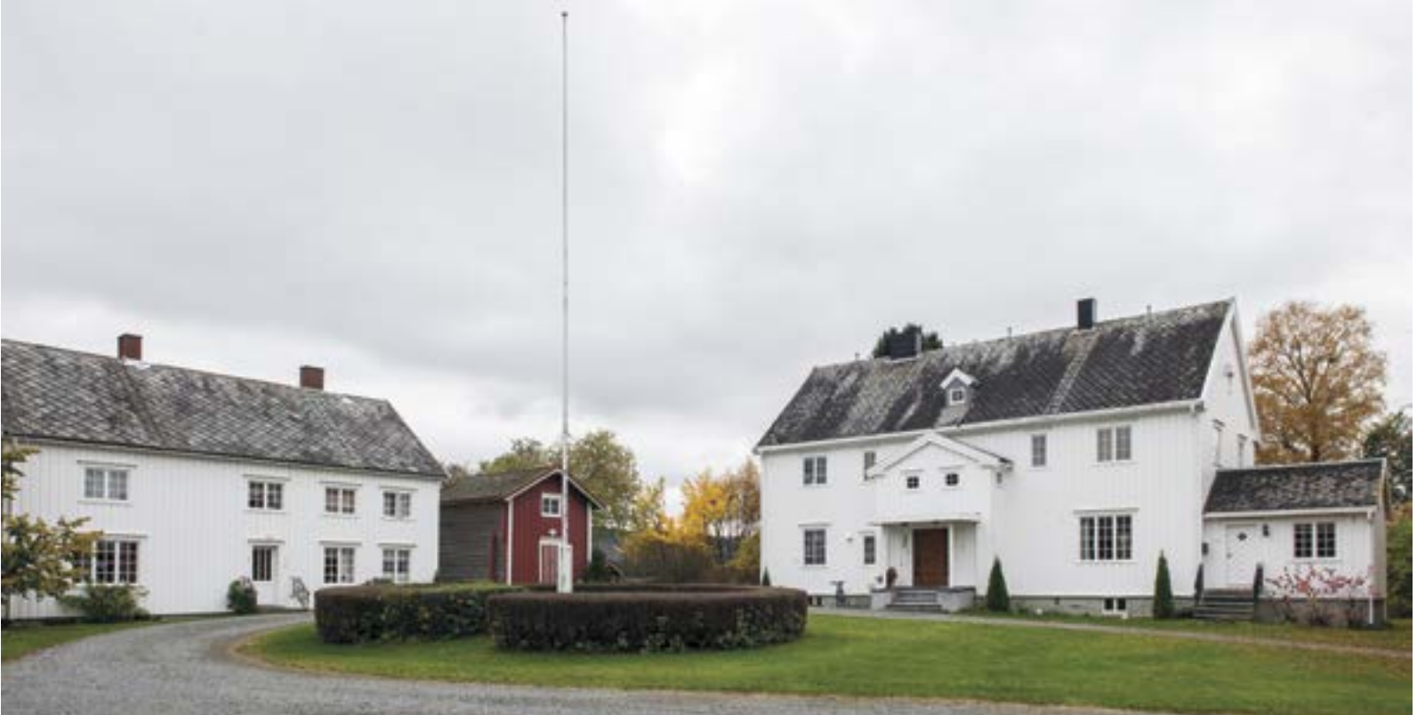
Verdal prestegård har et tun med gamle og nye bygninger. Forpakterboligen til venstre og Lars Solbergs prestebolig fra 1921.
