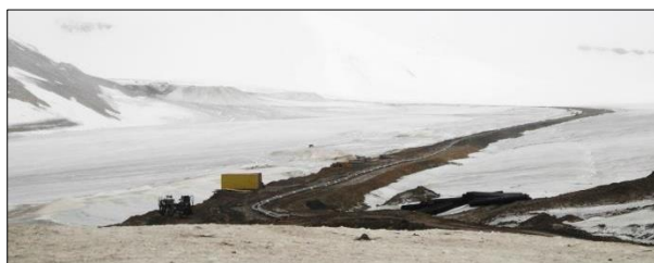
Bygging av veg over Marthabreen. Bilete: Trond Espen Haug/Sysselmannen på Svalbard
