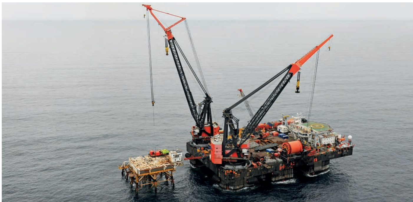
Figur 6.7 Tungløftfartøyet Balder forbereder fjerning av deksrammen på Edda (Foto: Kjetil Alsvik, ConocoPhillips)
