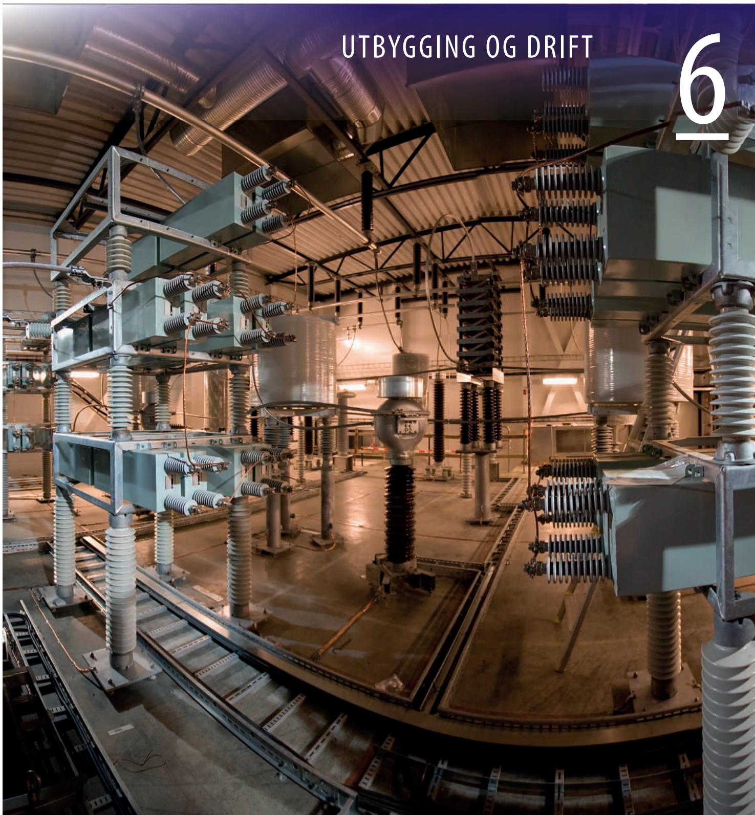
Lista omformarstasjon. Valhallfeltet sør i Nordsjøen blir drive 100 prosent av elektrisk strøm frå land via ein 295 kilometer lang kraftkabel frå Lista. (Foto: BP)
