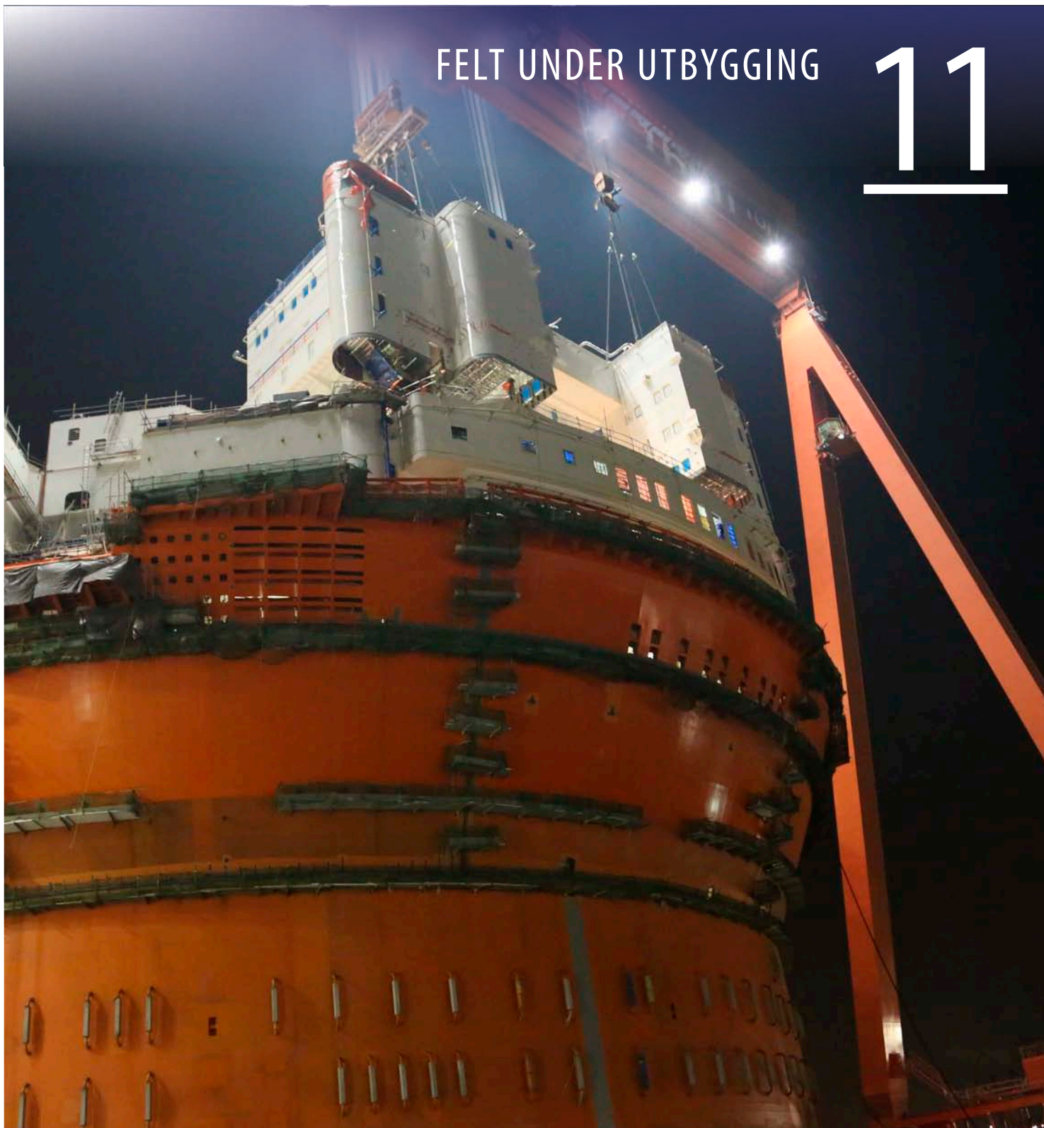
Bustadkvarteret blir løfta på plass på Goliat-innretninga. Den blir nå bygd på Hyundai-verftet i Ulsan i Sør-Korea. (Foto: Eni Norge, News on request)
