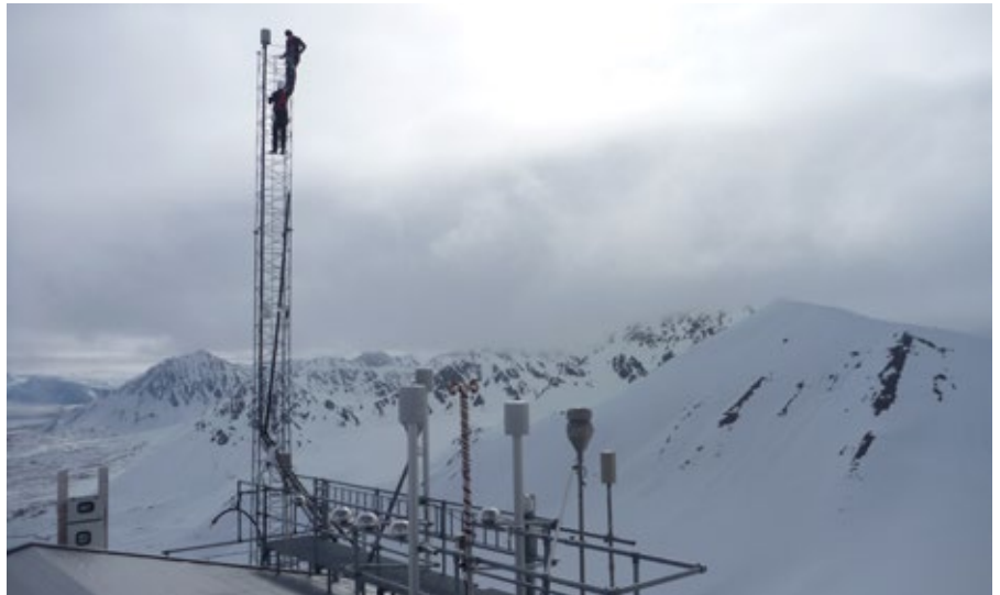
Ove Hermansen og Are Bäcklund fra NILU installerer luftinntak i masten ved NILUs observatorium på Zeppelinfjellet, Ny-Ålesund. Foto: Sanja Forsström, Norsk Polarinstitut
