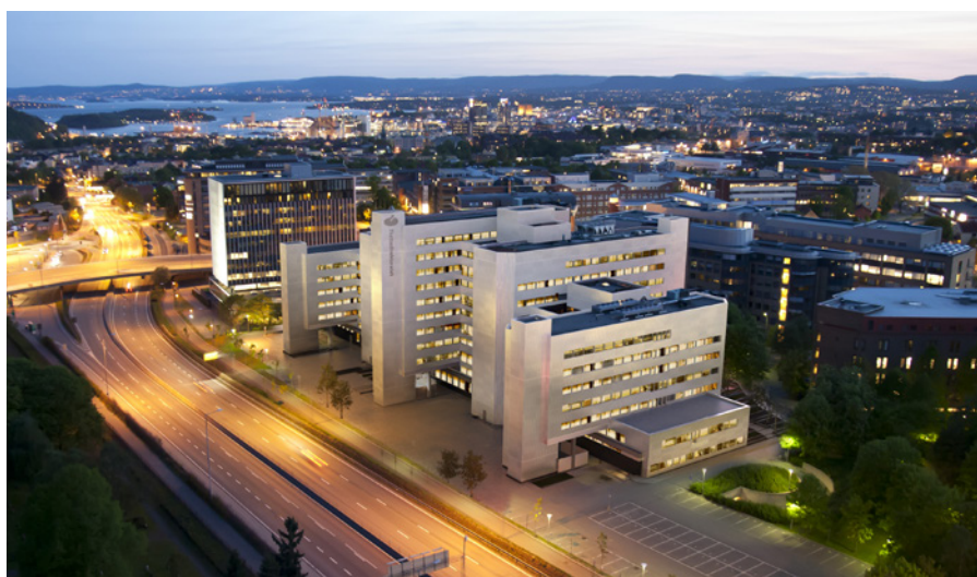
Fredrik Selmers vei 4 er det første rehabiliterte næringsbygget i Norge som oppnår passivhusstandard.
