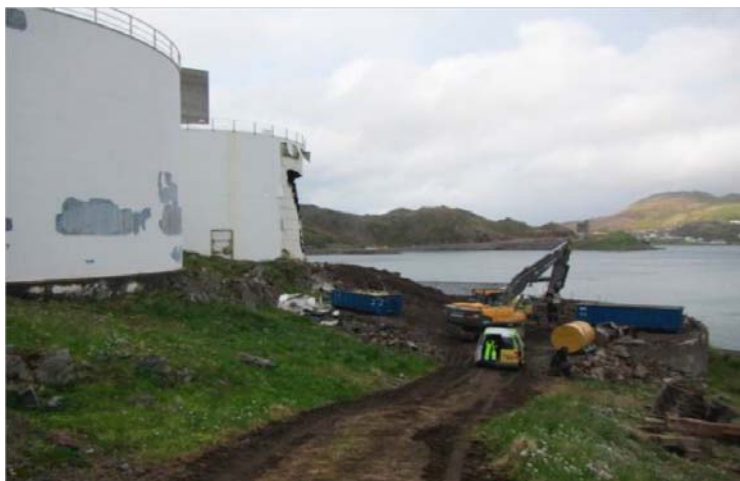
Bilde 3 Tungoljelekkasje fra bunkersanlegg i Honningsvåg
