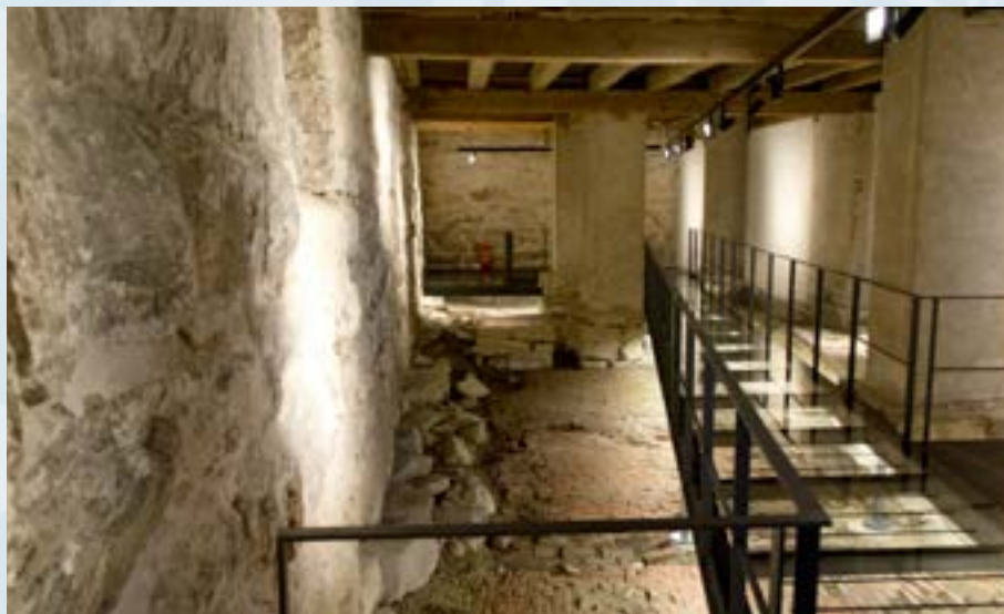
▲ Kjelleren som har vært ute av bruk siden 1844, har igjen fått liv og man kan se hvordan huset er konstruert. Arbeidet har avdekket både et teglgulv, muligens Carsten Ankers modernisering, og under det igjen hellegulv fra 1600-tallet. Funnet gjorde at man endret planen om å legge tekniske rom her. I stedet har man valgt å vise frem kjelleren slik den står nå. Her ser man hvordan bindingsveggene er laget: Strå spikret med ståltråd på panel, med puss over.
