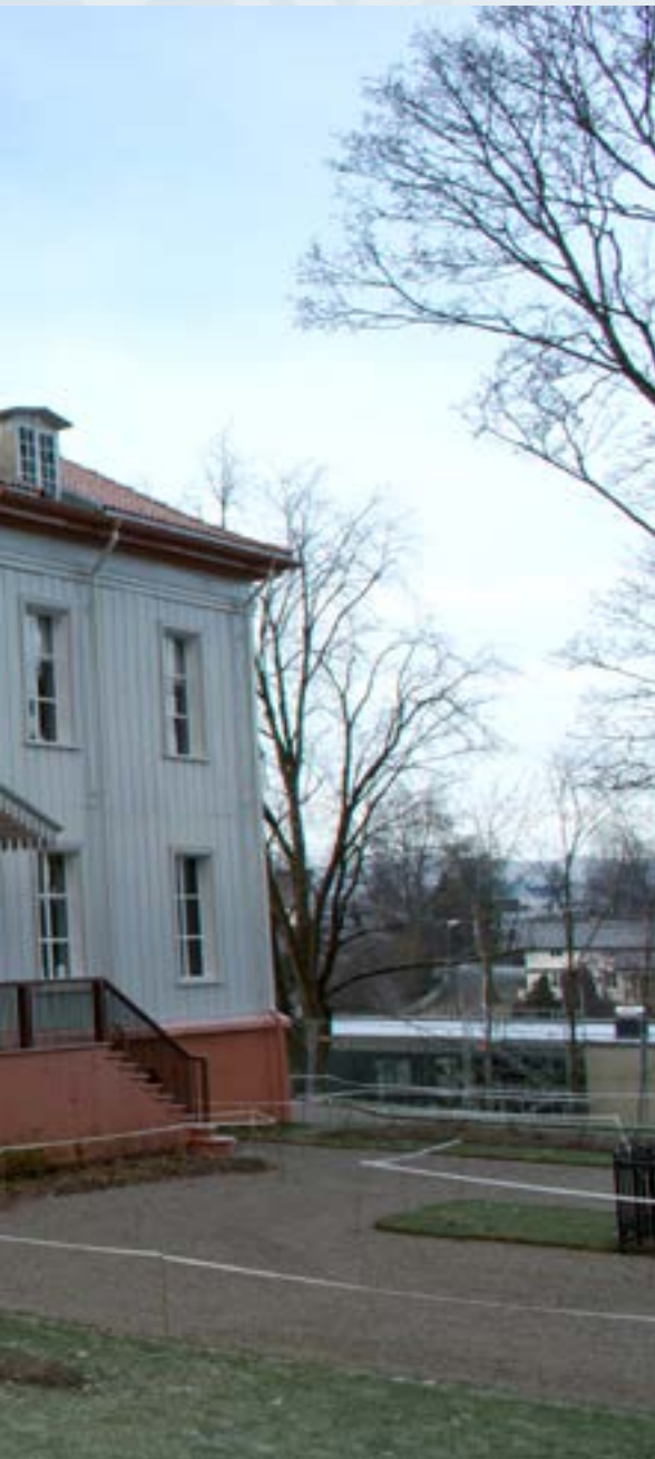
▲ Eidsvollsbygningen anno desember 2013. Grunnmuren er tilbakeført med vinduer og rødmalt puss som illuderer sandsten, som dekker granittmuren. Til venstre i bildet ser vi den nye inngangen for rullestolbrukere.
