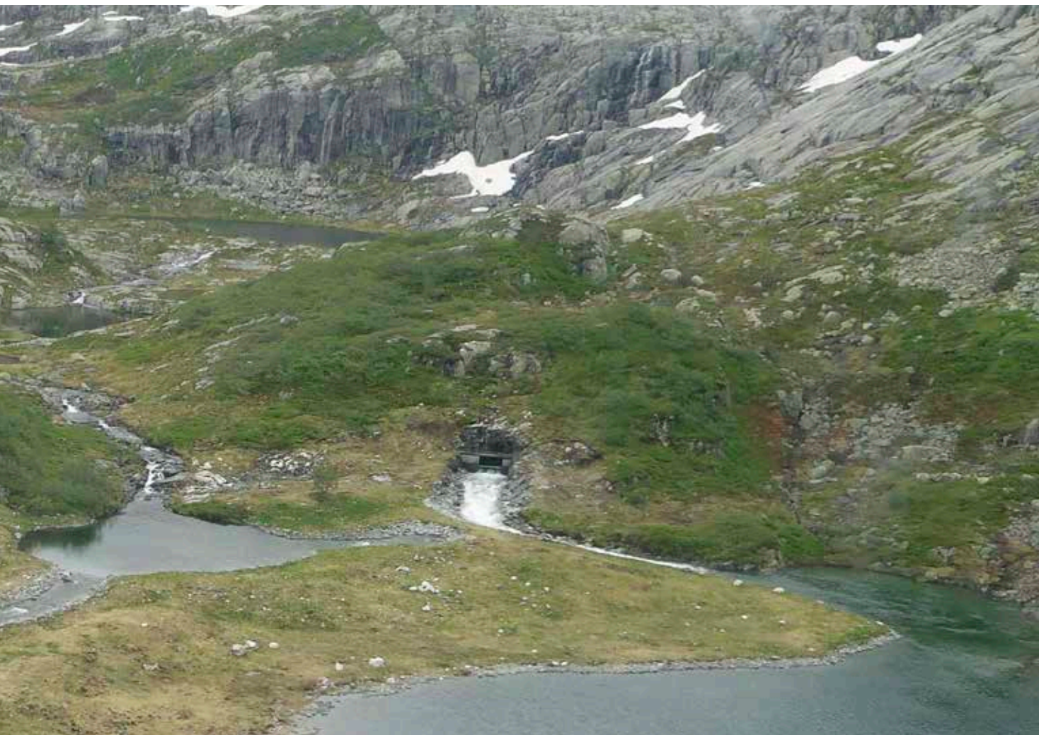
Nygglebeitevatn i Saudafjellene i Rogaland. Storstilt kraftutbygging i dette området førte til at 50 000m 3 med steinmasser måtte deponeres i høyfjellet. For å unngå sår i landskapet ble løsningen å anlegge en flat tipp i kanten av Nygglebeitevatn hvor det ble lagt inn en gytebekk fra tunnelen og ut i vannet. Tippen har nå ligget noen år og vegetasjonen har begynt å komme.
