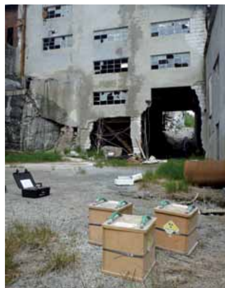
Etterlatne radioaktive kjelder vart funne i det nedlagte gruveanlegget Rødsand Gruber. Foto: Øivind Syversen, Statens strålevern.
