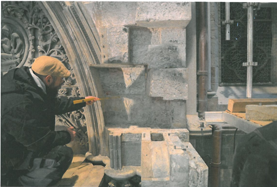
Demontering av Kongeinngangen
