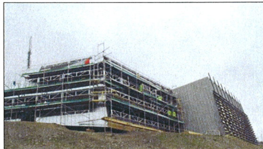
Sysselmannskontoret har fått nytt tilbygg i 2014. Foto: Arild Lyssand/Sysselmannen på Svalbard
