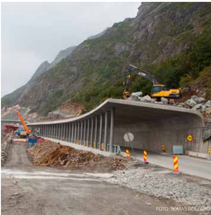
Fra rassikringsprosjektet på E10 på Hamnøy i Lofoten
