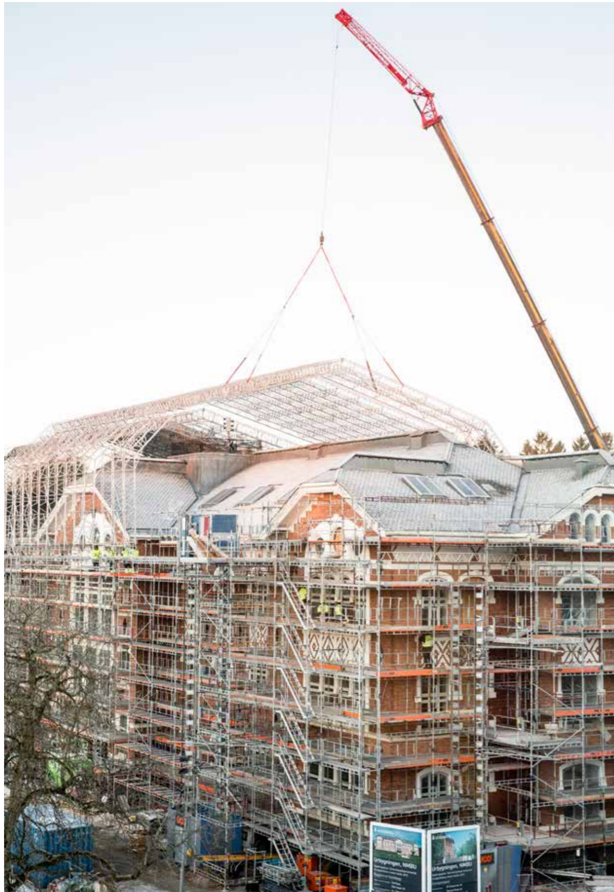
Montering av Norges største «Tak over tak». Rehabilitering av Urbygningen februar 2015. Foto: Gisle Bjørneby
