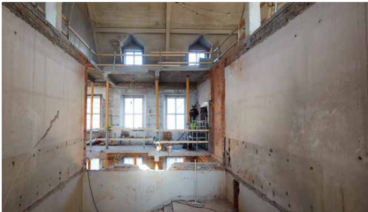
Trappen i Bybygg rives for å gi plass til nytt inngangsparti. Foto: Haakon Harriss.
