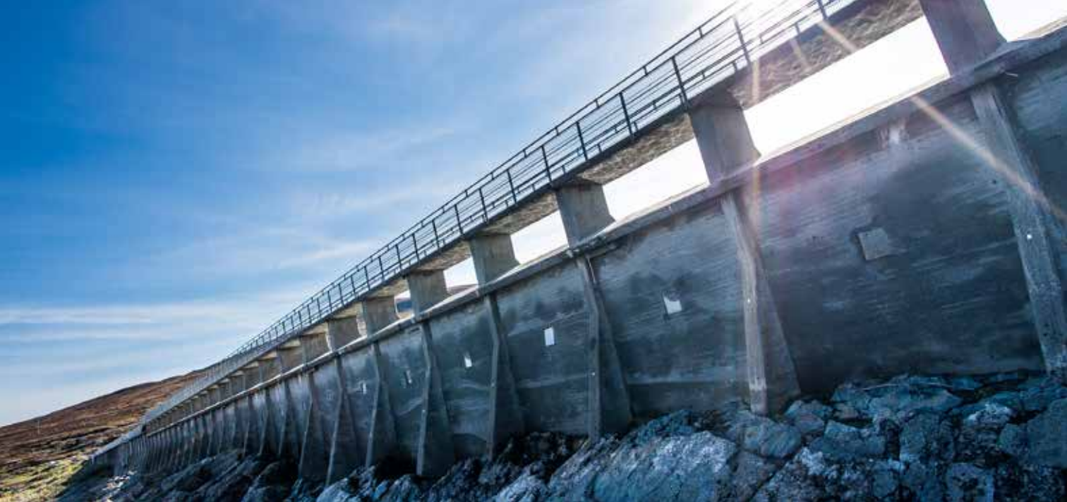
Dam Kalhovd i Tinn kommune i Telemark. Foto: Rune Engesæter/NVE.
