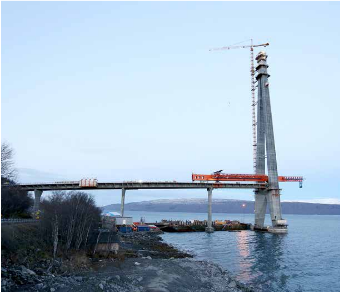
E6 Hålogalandsbrua – brutårn og viadukt. Foto Tomas Rolland
