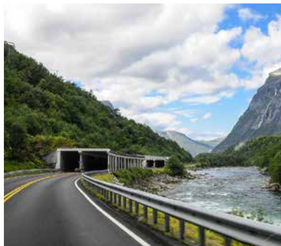
Rasoverbygg rv. 70 i Sunndalen. Foto: Knut Opeide
