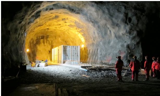
E39 Dregebo-Grytås Bygging av Økslandstunnelen Foto Vegard Bondevik Lie
