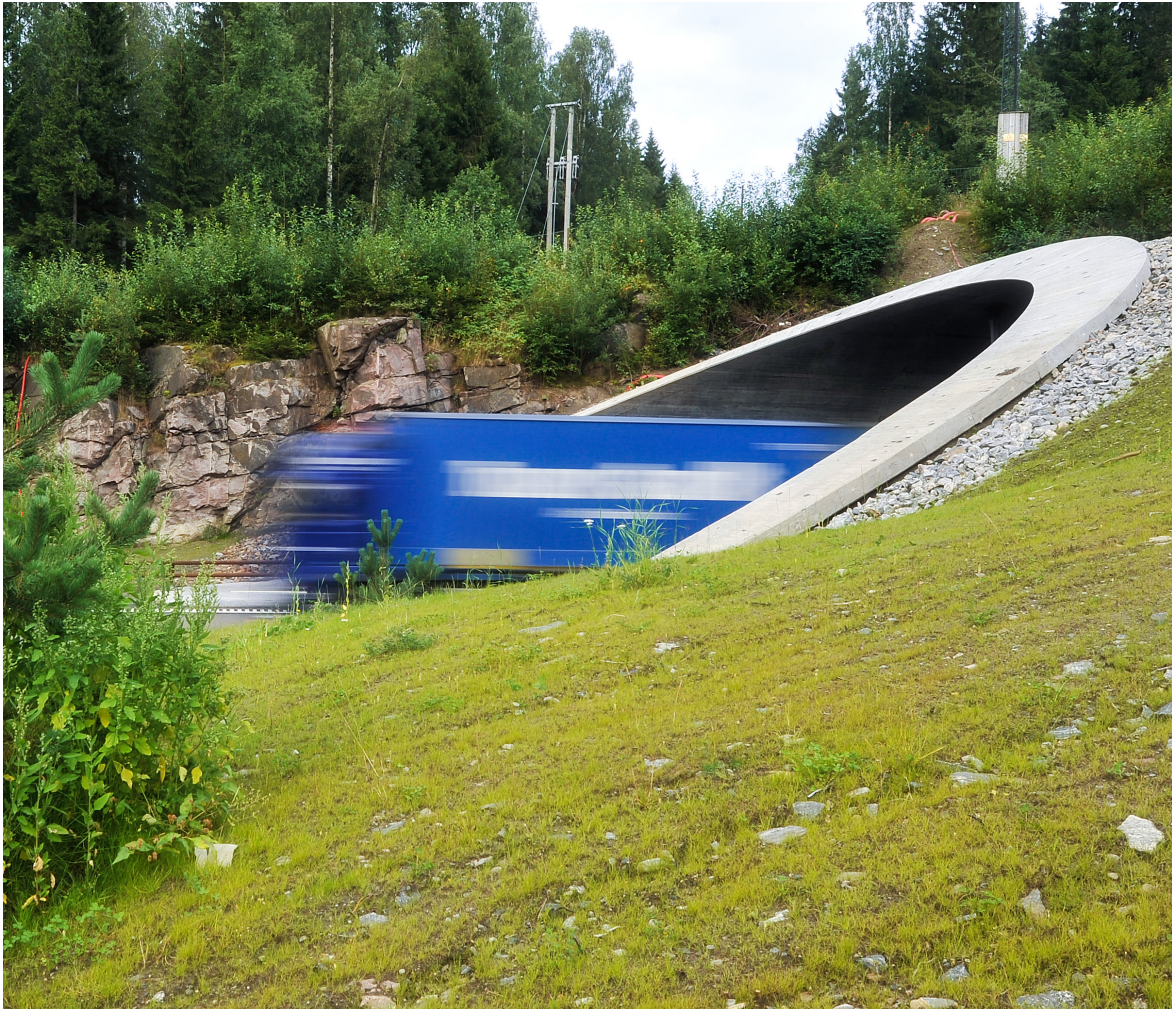
E6 Eidsvolltunnelen. Foto Knut Opeide
