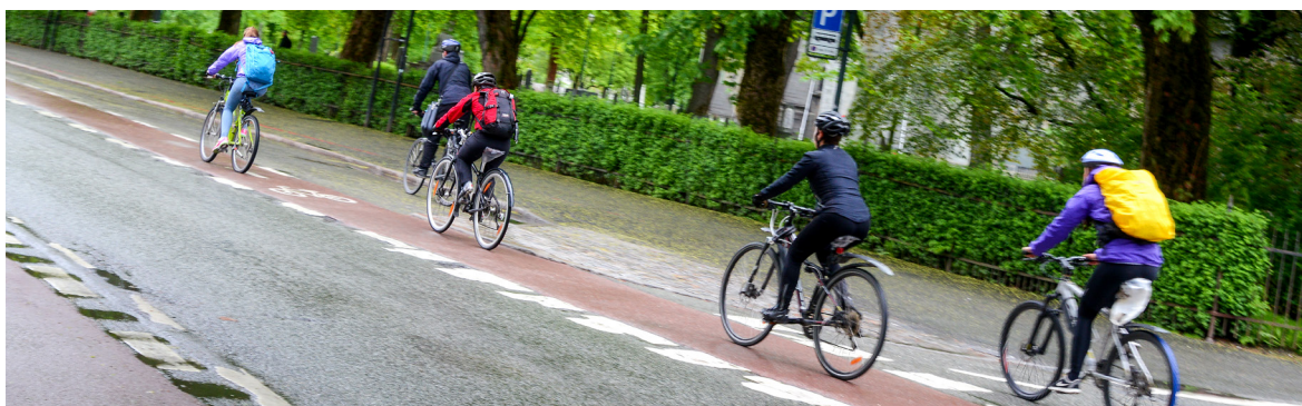
Bispegata Trondheim. Sykkelfelt med rød asfalt. Foto Knut Opeide
