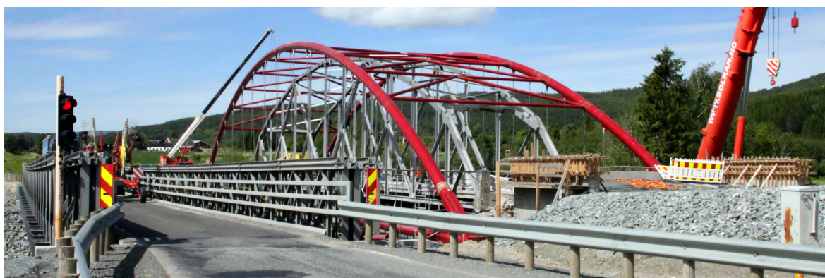
E6 Forra bru under bygging. Foto Rune Eian
