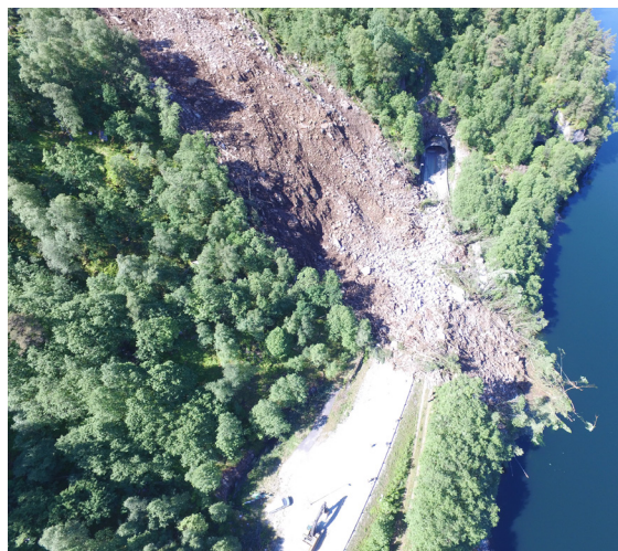
E16 Ras over Hyvingtunnelen. Foto Harald Hauso
