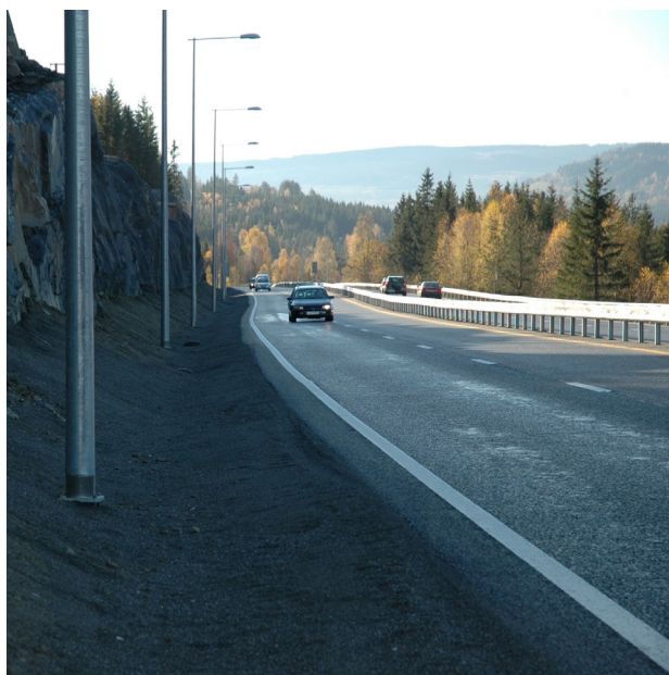
E6 Hunderfossen_Firefeltsveg med sideterreng fylt opp mot fjellskjering og lysmast med knekkledd.
