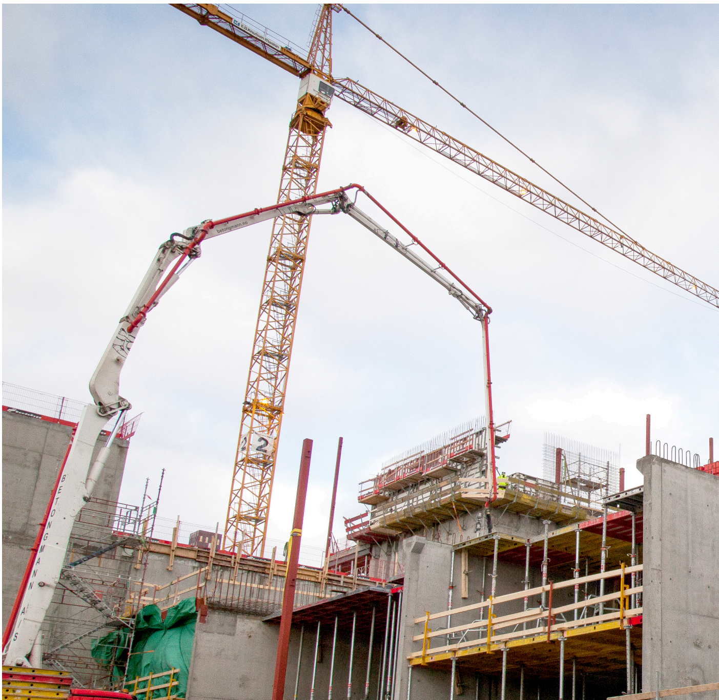
Byggeplassen for det nye bygget der veterinærene skal inn. Foto: Kai Tilley
