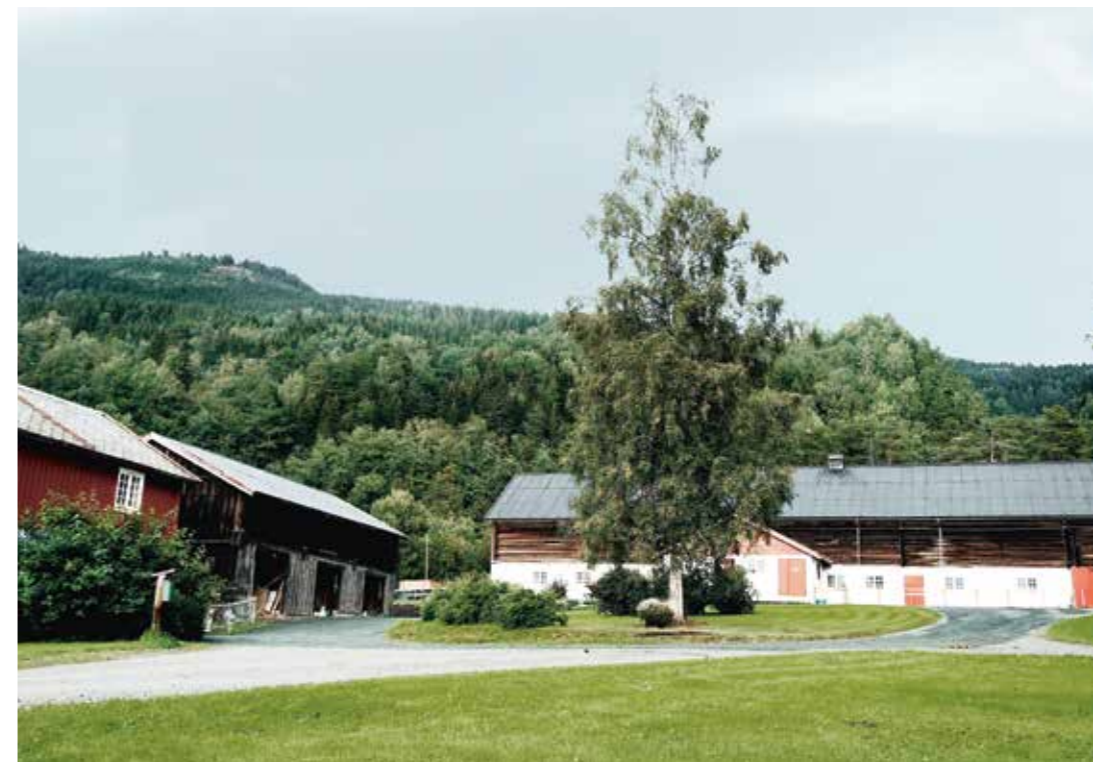
På Meldal prestegård i Trøndelag ble det i 2017 investert i melkeproduksjonen og det ble reist ny fjøsbygning.
