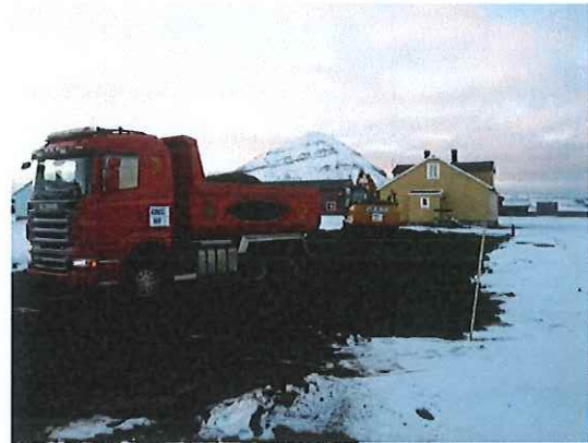
Fra tomta til nytt felles forskningsbygg. Foto: Per Erik Hanevold
