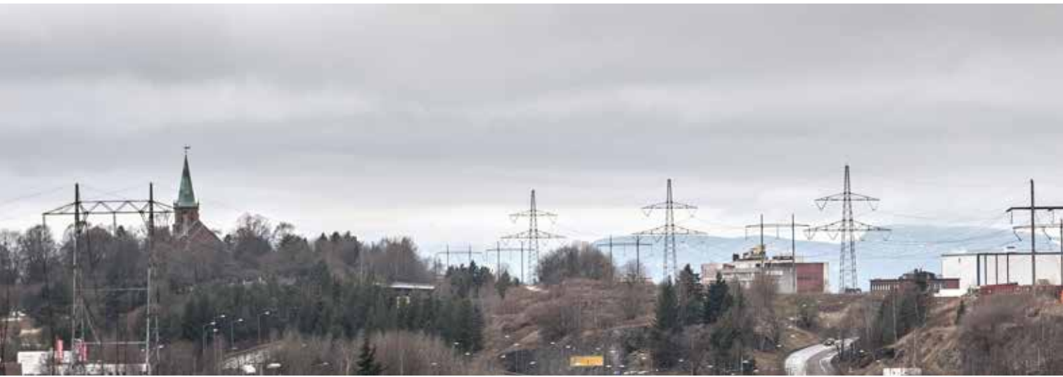
Høgspenning i urbant miljø, Oslo. Foto Stig Storheil, NVE
