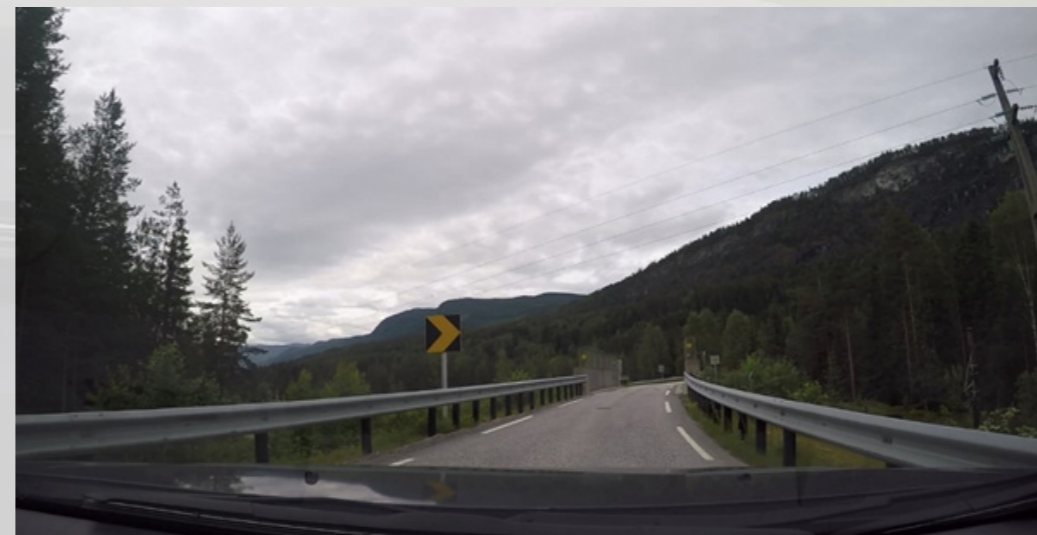
Smal bru, maks bredde 3,6 meter, med bratt stigning inn til bro. Kan medføre trafikal problemer, spesielt for vogntog på vinterstid.
