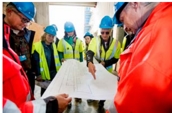
Ivrige tilsette på befaring. Foto: Håkon Sparre.
