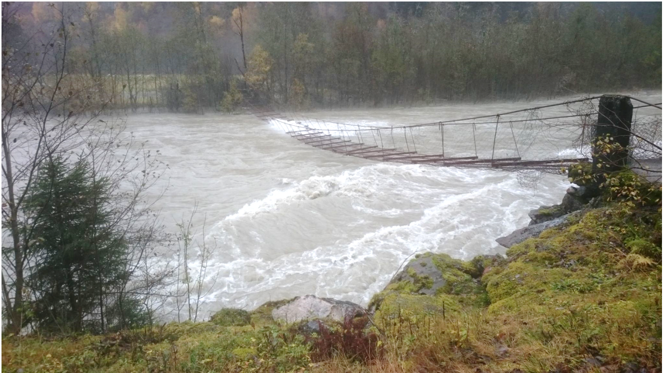
Under et ekstremt regnvær i oktober 2018 klarte Statkraft å vesentlig redusere omfanget av en større flomsituasjon, fra en 50-årsflom til en 20-årsflom.
