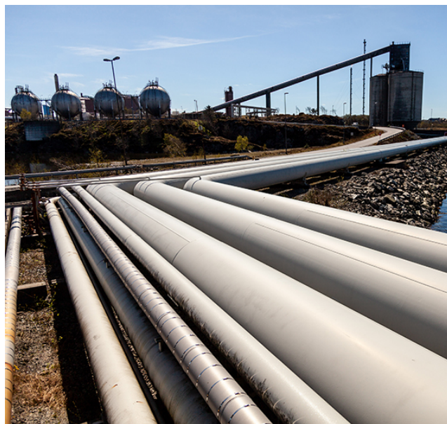
Installasjon av rørledninger fra Johan Sverdrup på Mongstad, Norge
