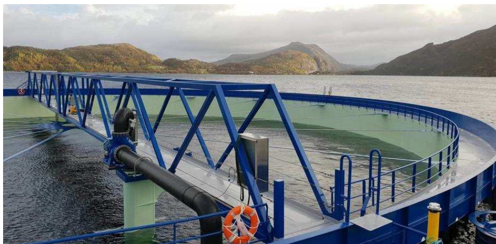
Figur 27: Midt-Norsk Havbruk Produksjon sin semilukkede stålmerd Aquatrax (nr 1 av 4) på plass på lok. 35877 Eiterfjorden i Nærøy kommune
