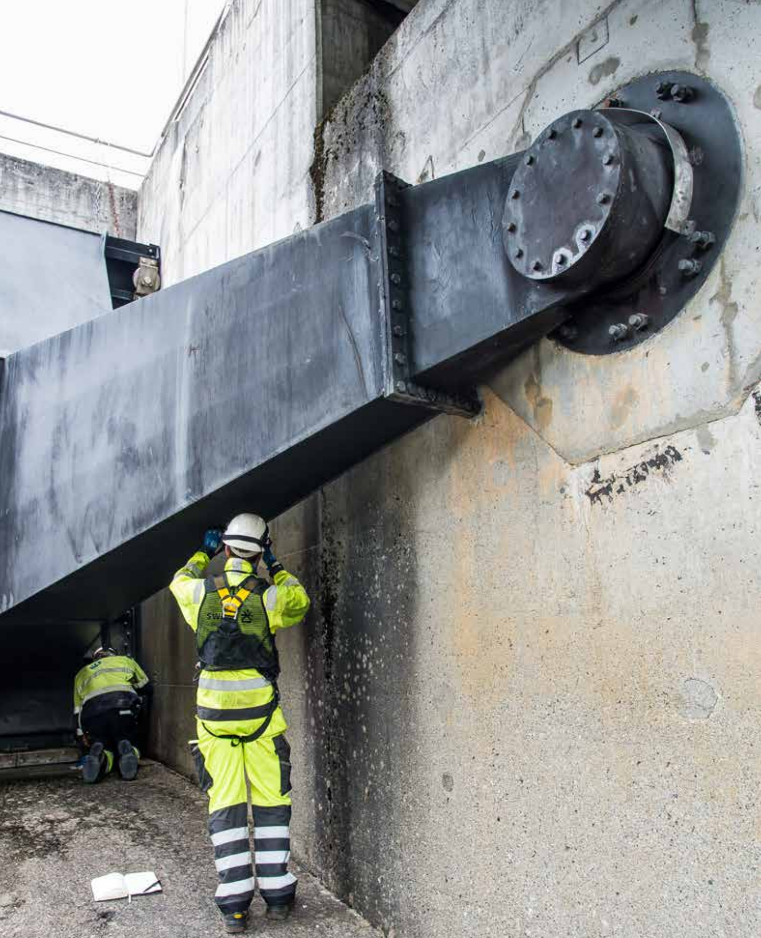
Hovudtilsyn på dam Svelgfoss i Notodden kommune, Telemark. Hovudtilsyn blir utført minst kvart 5. år og er ein omfattande inspeksjon og vurdering av tilstand og funksjonsdyktigheit som mellom anna inkluderer funksjonsprøving av flaumluker. Ved hovudtilsyn ser ein etter forhold som kan redusere tryggleiken til anlegget. Foto: Rune Engesæter, NVE
