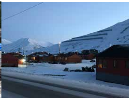
Longyearbyen, Svalbard. I bakgrunnen ser ein snøskredssikring på Sukkertoppen. Foto: Erik Due, NVE.
