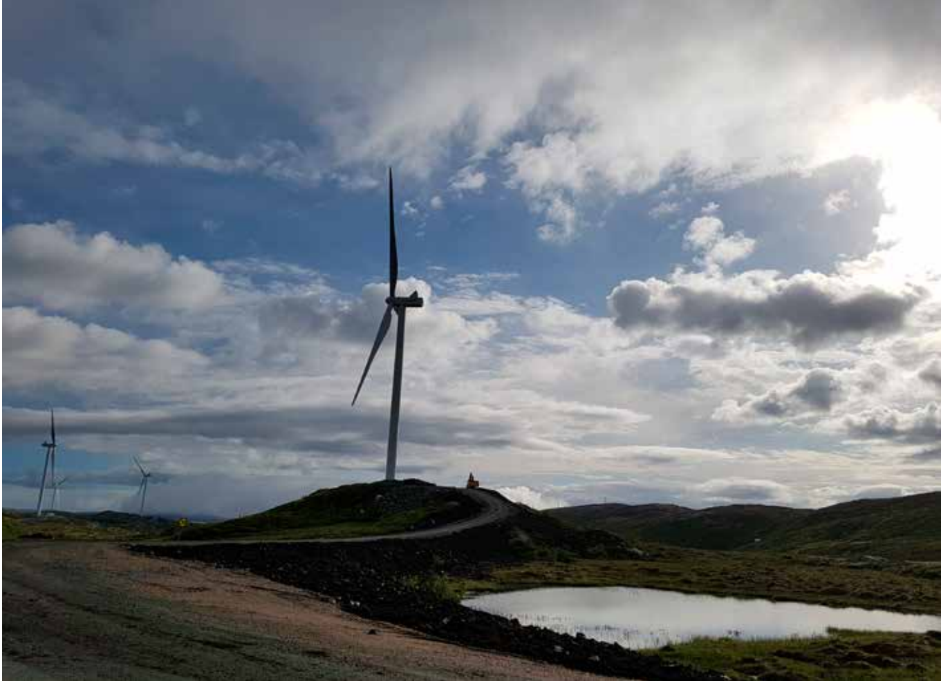
Miljøtilsyn på Roan vindkraftverk i Trøndelag. På denne synfaringa såg vi korleis terrengingrepa etter bygginga var sett i stand. Foto: Inger Helene Waagaard Riddervold, NVE
