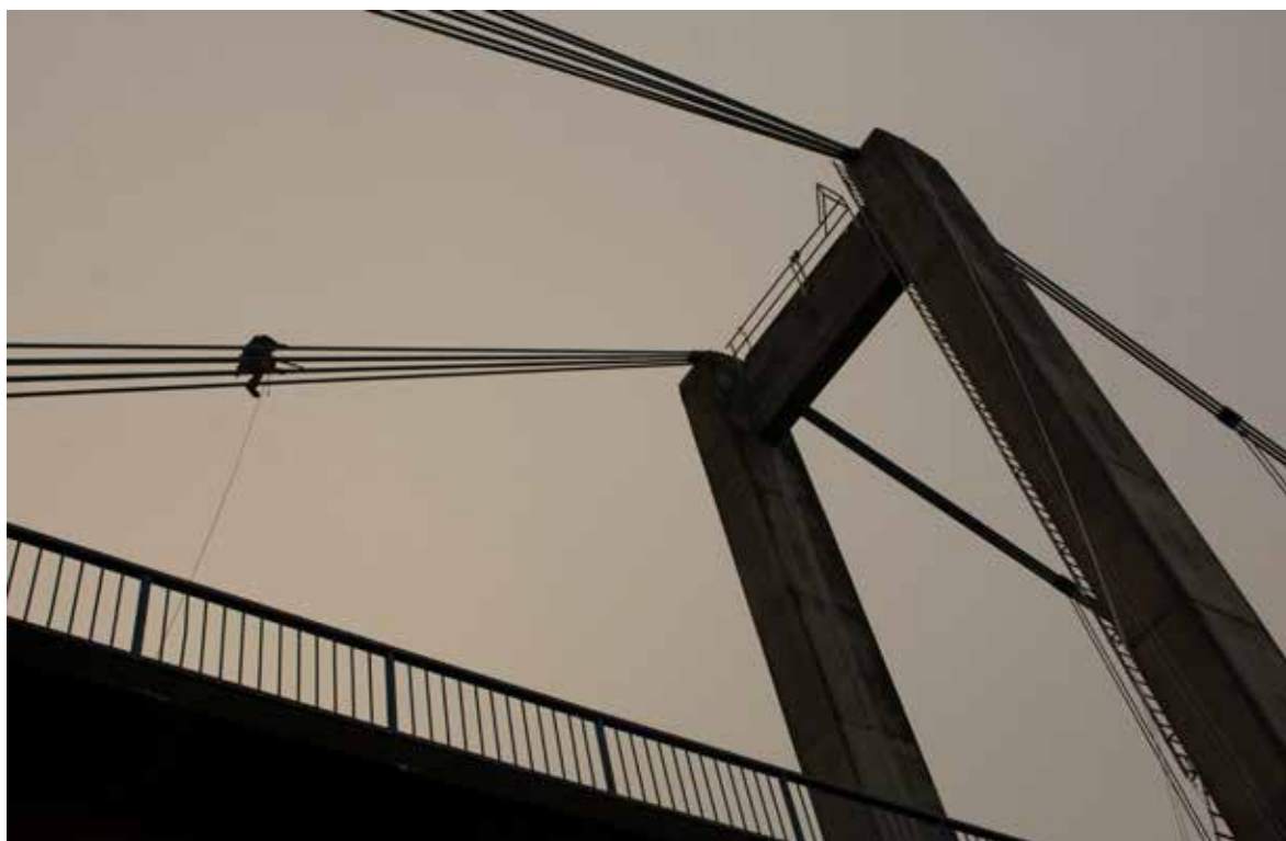
Inspeksjon av Randøy bru. Foto: Bjørn Egil Gilje
