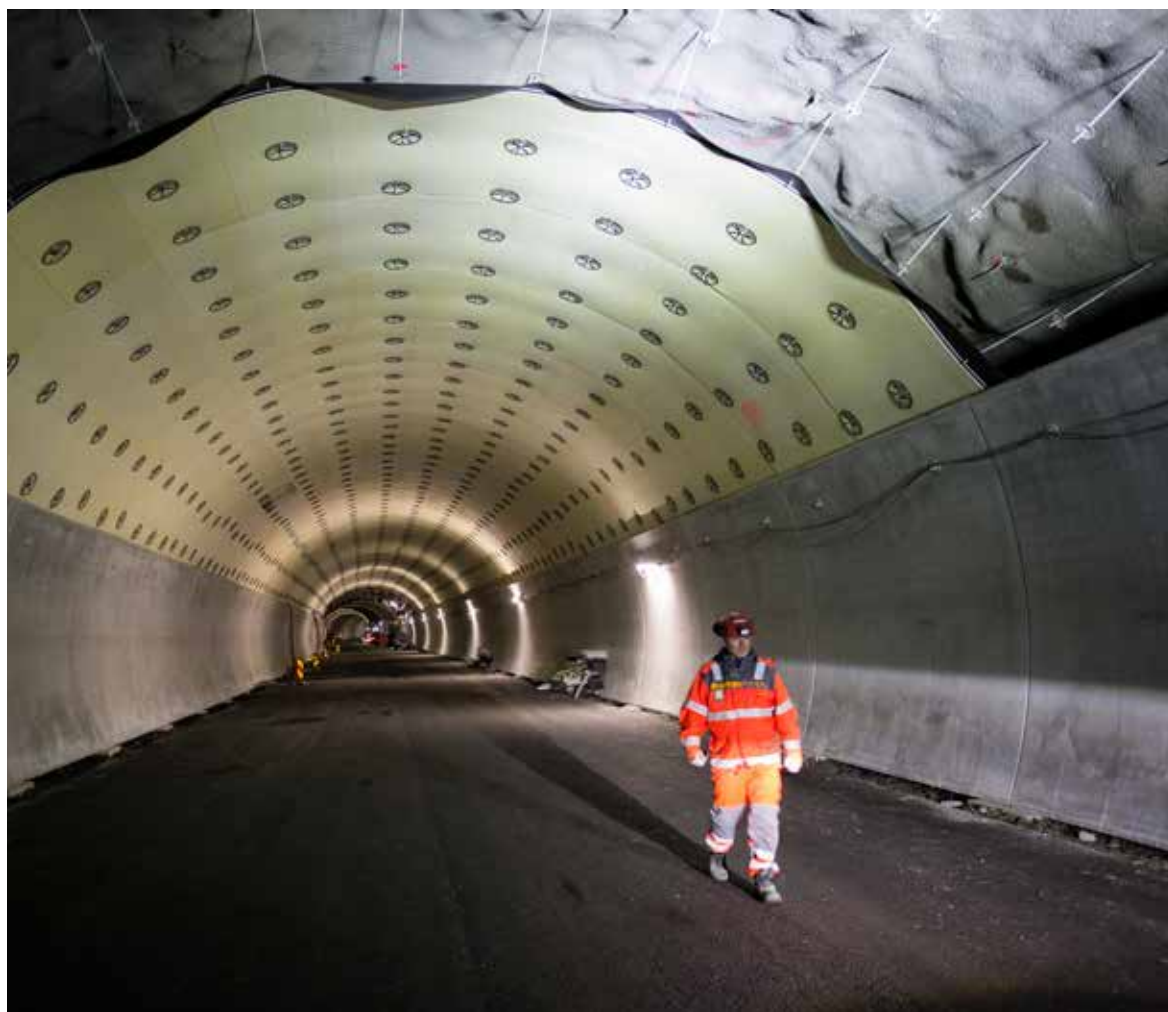
Bygging av ny sentrumstunnel som del av Harstadpakken i Troms. Foto: Tomas Rolland
